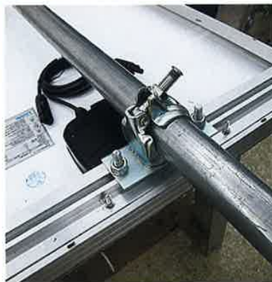
(上)ソーラーシェアリング上総鶴舞発電所。出力35kW (下左)高澤 真氏(右2人目)NPO世界環境改善連合の仲間たちと、アルミレールの取り付け作業 (下右)特殊クランプに単管パイプの取り付け
