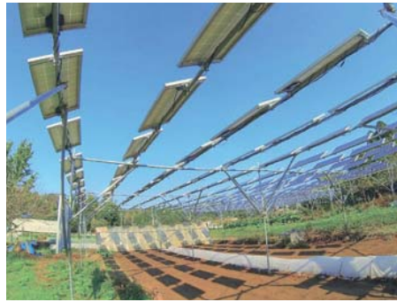
上：ソーラーシェアリング上総鶴舞 右：下からの写真。2.5～3.5mほどの高さの間隔を空けて太陽光パネルを並べる。 【写真提供／高澤氏】
